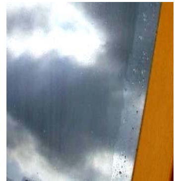
Naßversiegelung: Silikonöle können aus Silikon-Dichtstoffen auf die hydrophile Schicht kriechen. Die Folge kann ein hydrophober Bereich am Rand sein (Tröpfchenbildung).
